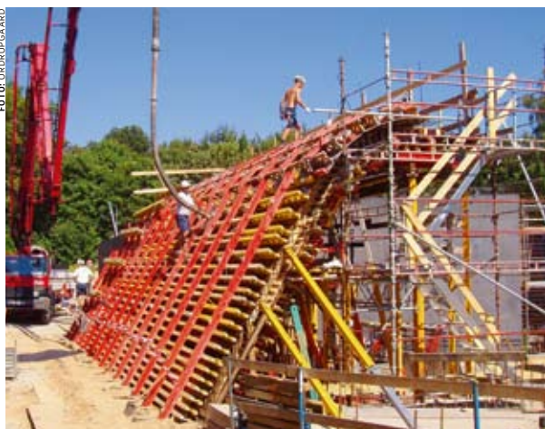
Ved Ordrupgaards nye tilbygning er støbeprocessen foregået på byggepladsen, hvor store støbeforme blev opstillet til fremstillingen af de buede vægge, der både krummer op mod taget og ind under gulvet. Væggene er konstrueret af to betonskaller med isolering imellem. Støbningen af skallerne er sket ved, at sort selvkompakterende beton er blevet presset ind i formene nedefra.
