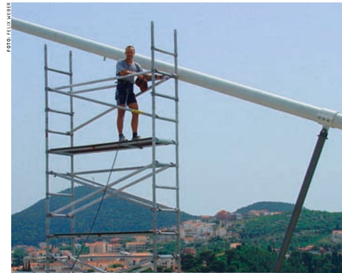
Felix Weber i arbejde på Franjo Tudjman-broen i Dubrovnik, Kroatien. Den første bro, hvor kablernes svingninger er dæmpet med aktive dæmpere.
