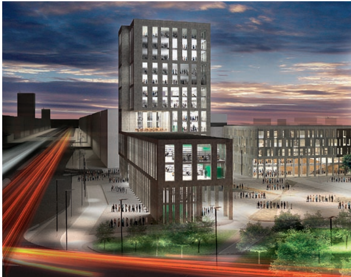
De traditionelle energibesparende foranstaltninger som isolering og lavenergiglas blev suppleret af en geometrisk optimering.
