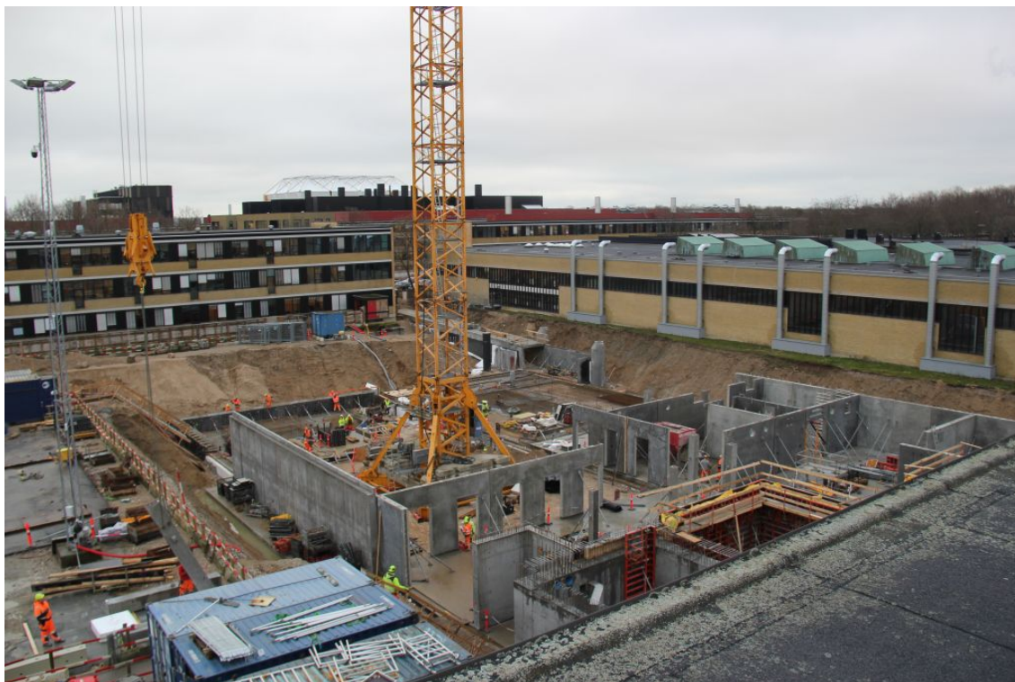
Byggeplads bygning 310, januar 2018. Nyt Fysik og Energi Byggeri
