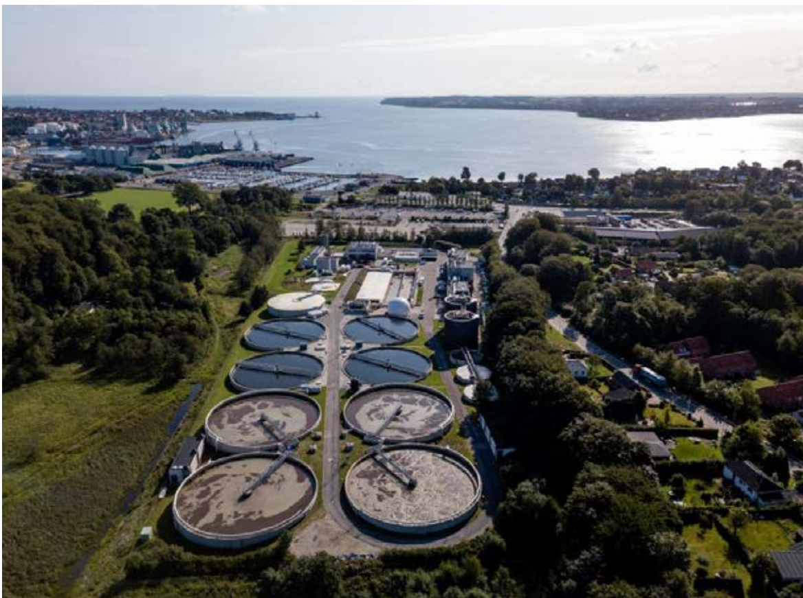
Energifleksibilitet i alle dele af samfundet er nøglen til en effektiv omstilling til et energisystem drevet af vejret. Figuren viser Fredericia Spildevand og Energi. Håndtering af spildevand bidrager med betydelig fleksibilitet ved rensningen (primært beluftningen), pumpning i kloaksystemet, og endda ofte med en positiv og fleksibel energibalance ifm. produktion af energi baseret på biogas.
