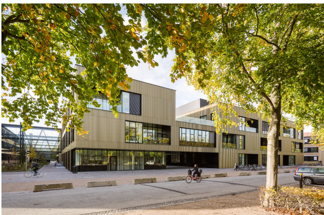
Bygning 202 | Life Science & Bioengineering byggeriet.
